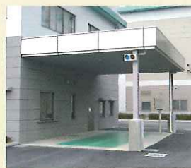
1 計量機 搬入されるごみを計量・記録します。
