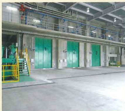
2 プラットホーム 収集車で運ばれてきたごみをここからごみピットへ投入します。
