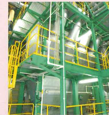
9 集じん器 ガス中に消石灰を吹込み塩化水素などの有害物質をばいじんと共にバグフィルタで除去します。
