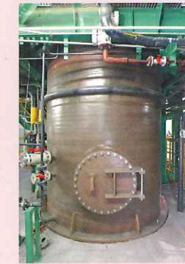
13 触媒反応塔 尿素水を噴霧して窒素酸化物を分解します。
