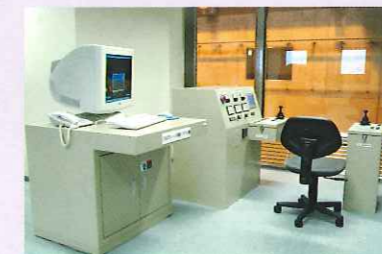
●クレーン操作室 クレーンでごみを攪拌した後溶融炉に投入します。
