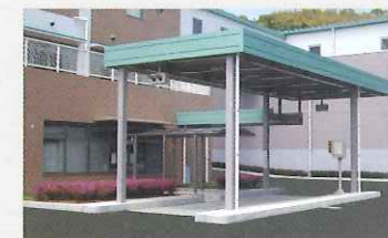
計量機 搬入されるごみを計量・記録します。
